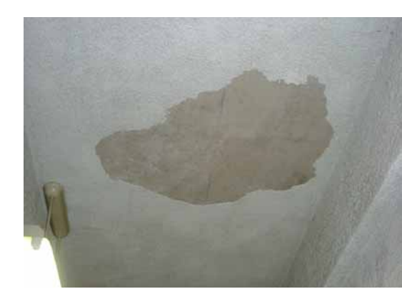
剥がれ落ちた吹きつけ石綿（アスベスト材）
