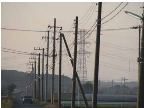
防犯灯 【東地区】
