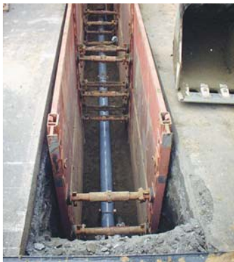
▲ 下水道管布設工事
