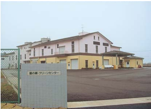
▲ 龍の郷 クリーンセンター [汚泥再生処理]
