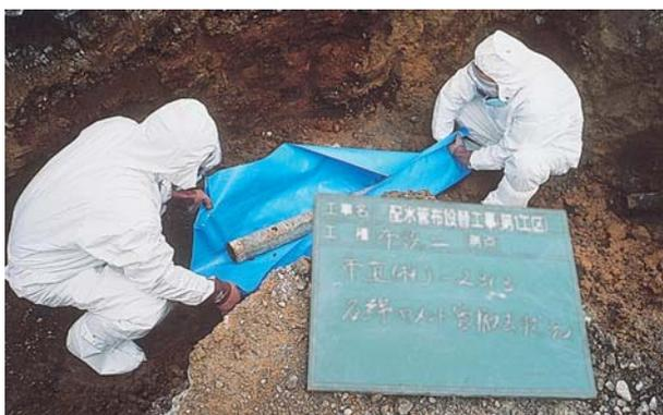
▲ 石綿管布設替え工事
