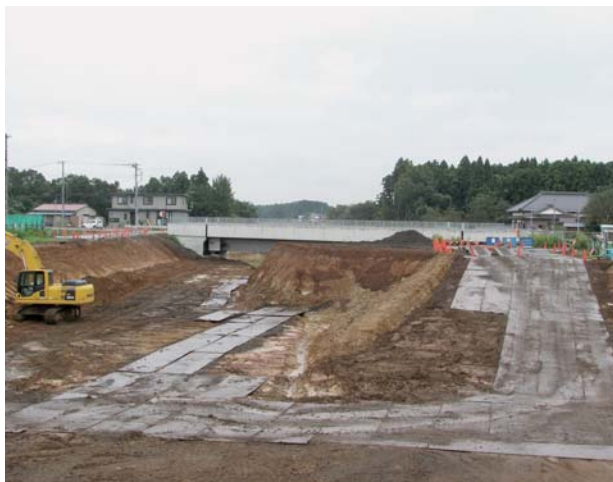
▲ 建設進む圏央道
