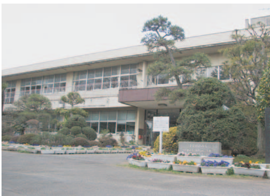
老朽化の進む小学校の校舎
