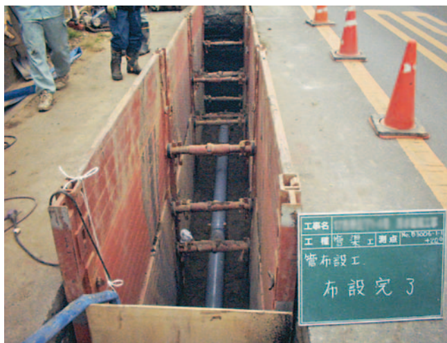
インフラ整備のための公共工事
