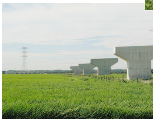
平成24年度の開通に向けて建設中の圏央道
