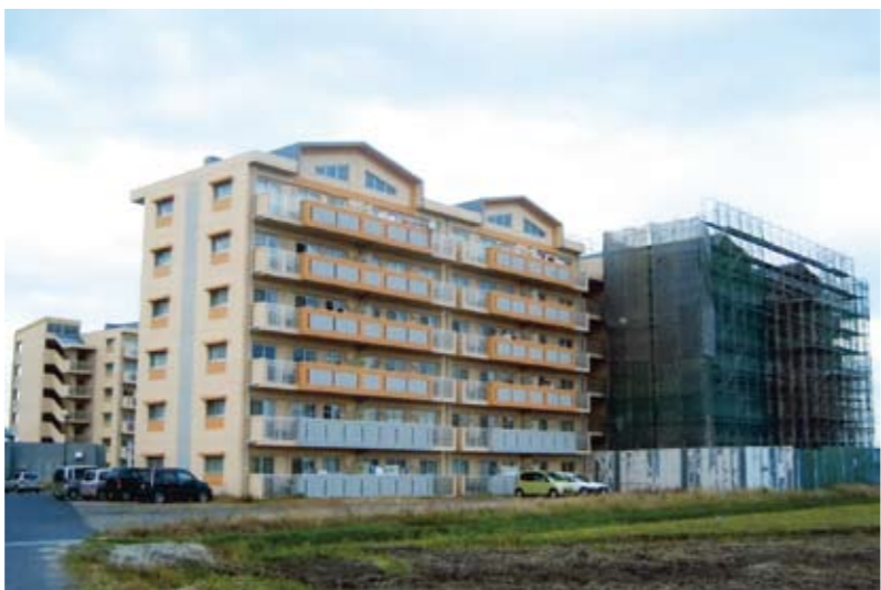
▲工事が進む第2期結佐市営住宅(向かって右)
