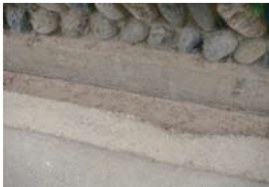
下水道に接続し、生活排水が流れなくなったために乾燥している道路側溝の様子
