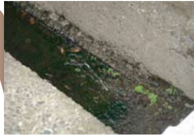
下水道への接続前の、生活排水が流れ込んでいる道路側溝の様子
