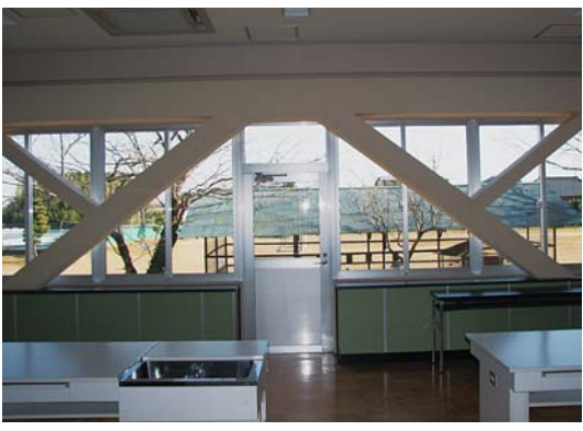
耐震改修を終えた小学校舎
