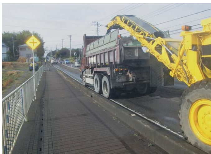
優先度を考慮してすすめられる公共工事
