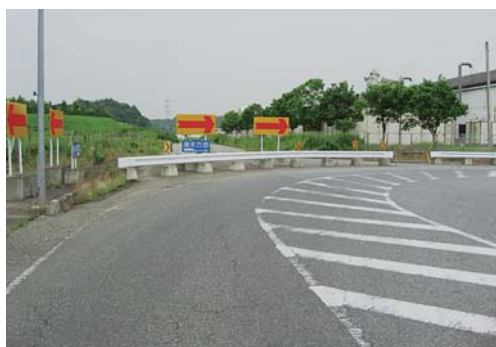
工事がまたれる竜ヶ崎潮来線バイパス
