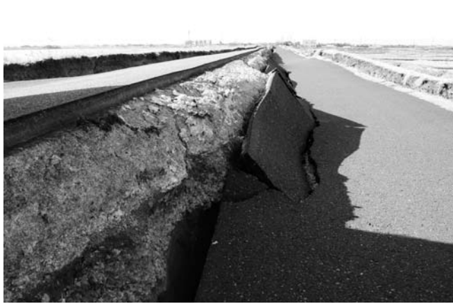
▲稲敷大橋から数百メートル東地区に向かった新利根川沿いの道路。50cm以上の段差ができた。(表紙の写真はこの対岸の道路です)
