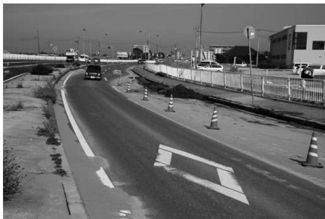
▲地震から3日後の国道51号西代地区。液状化による水はおおた引き、後には大量の砂が残された。数日後には強風が吹き、砂嵐となった。
