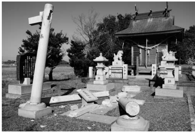
▲神社の鳥居が完全に壊れてしまった。この他にも墓石や石材が多数崩れているところが見受けられた。(本新地区の鹿島神社)
