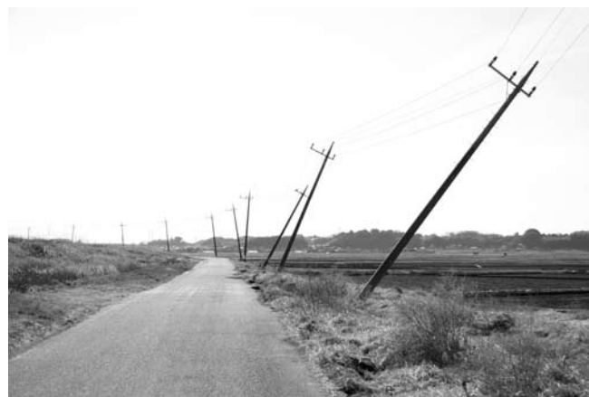
▲江戸崎地区でも地震の影響は数か所に出た。特に稲波干拓では、道路舗装面の亀裂の他に、電柱も傾いていた。
