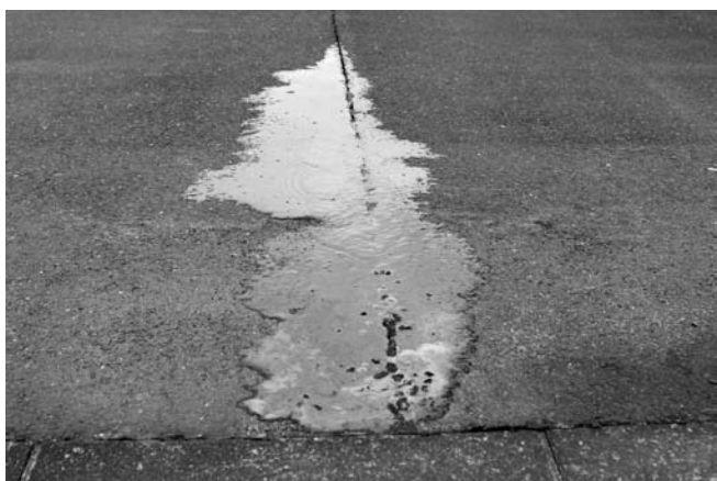
▲地震直後。液状化による水の吹き出しが始まる。アスファルトの下からは、まるで船着き場のような水の音がして、液状化の恐ろしさを思い知らされた。
