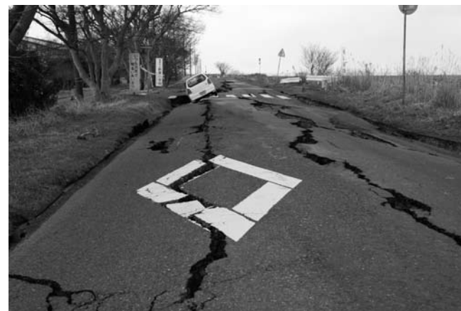
▲新東小学校前も大きな亀裂が入り、通行止めのポールが立てられた。
