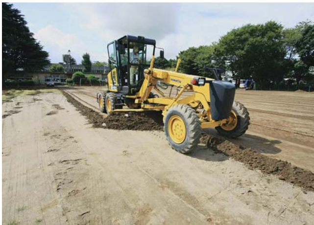
重機による除染作業
