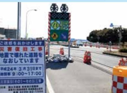
▲交通量の多い国道51号線。一車線は工事が終わり、残りの一車線を現在工事中です。
