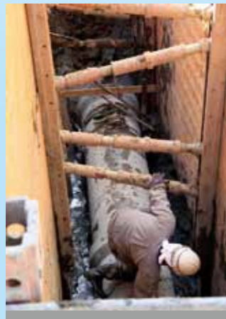
▲下水道管の敷設作業。この行程が終わらないと上水道や道路工事が始まりません。
