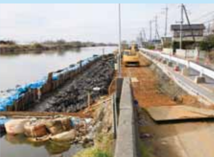
▲新利根川沿いの国道125号線。川の水をせき止めながら、工事が行われています。
