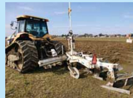
▲液状化した田んぼの土をこの耕作機を使って天地返しをしていきます。
