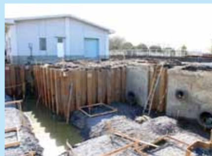
▲水田の心臓部ともいべき機場。急ピッチの作業が進められています。
