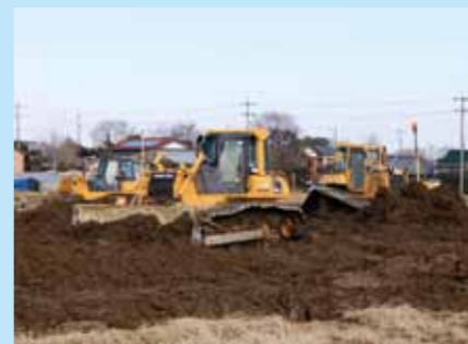
▲天地返しをした土をレーザー水準器を付けたブルドーザーが平らにしています。
