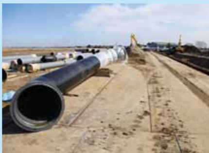
▲このパイプが地中深く設置され、それぞれの田んぼに水を送っていきます。
