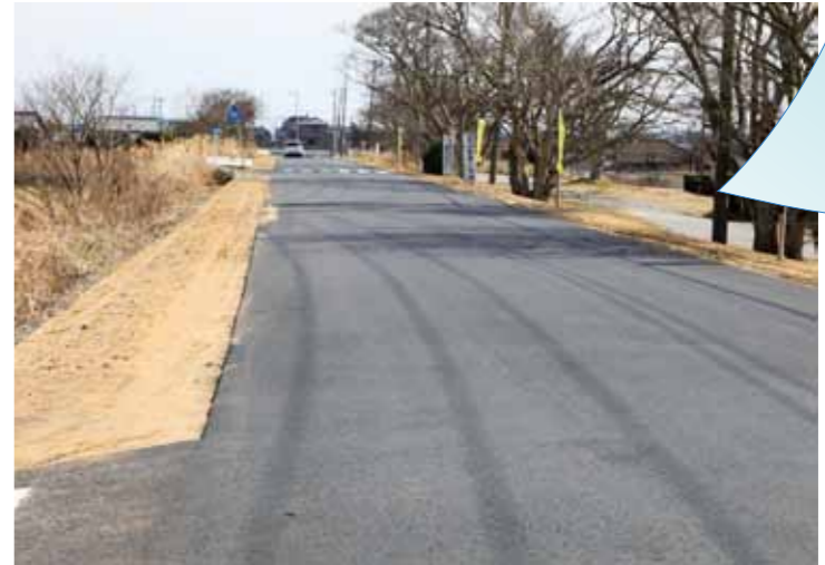
新東小学校前の道路
