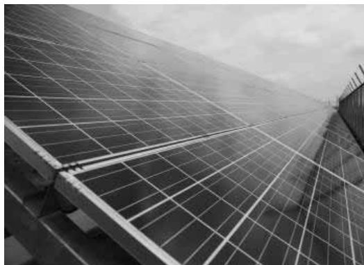
東中学校太陽光パネル
