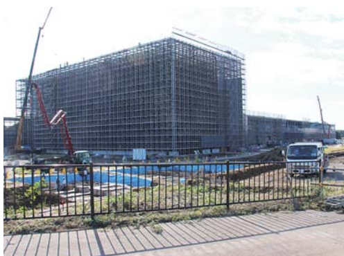
建設の進む物流センター（江戸崎工業団地）
