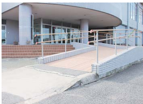
江戸崎体育館前スロープ
