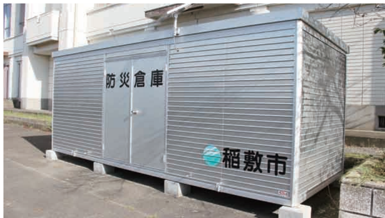
東中に設置された防災備蓄倉庫
