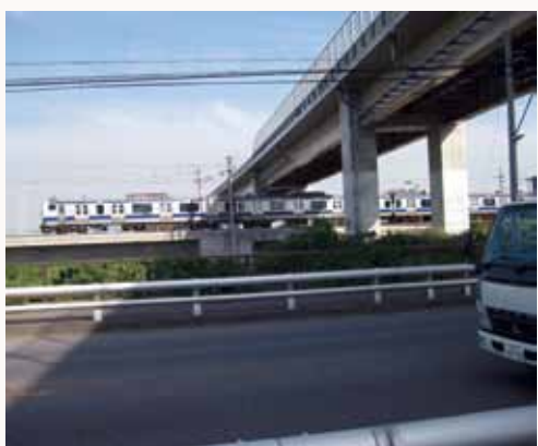
△国道6号線小野川橋と常磐線架橋、圏央道
