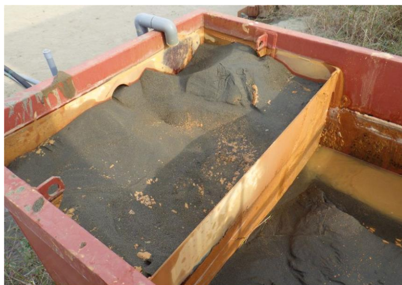
写真 2.3.2 揚水時のノッチタンクの砂堆積状況
