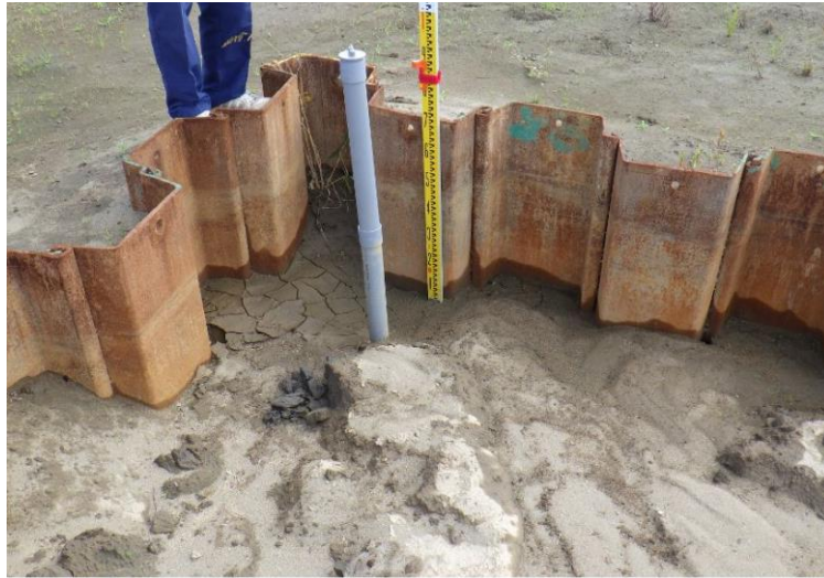
写真 2. 3. 3 矢板頭部と地表面の高さの状況
