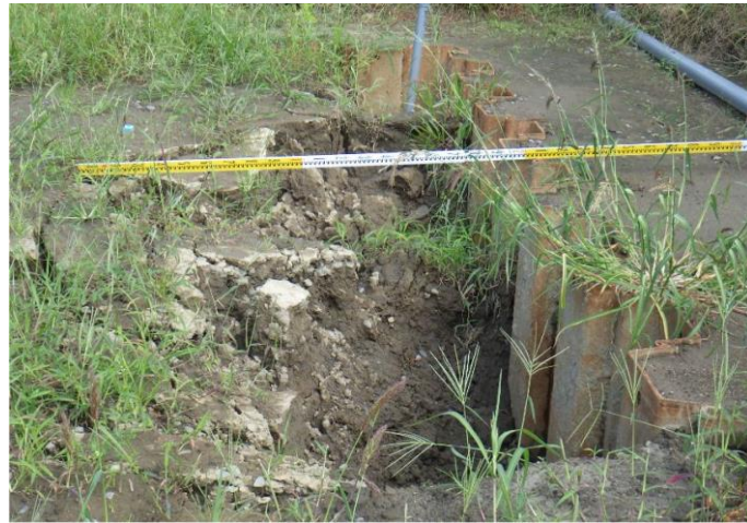
写真 2. 3. 4 揚水後の陥没箇所状況
