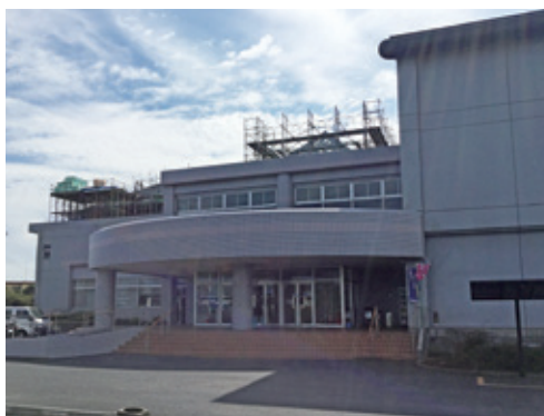
改修中の江戸崎体育館
