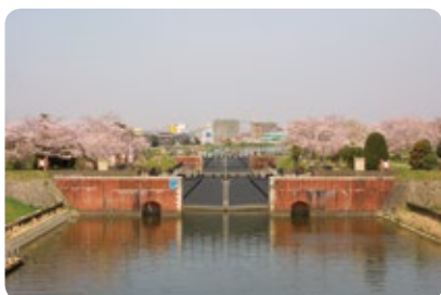
国指定重要文化財横利根閘門
