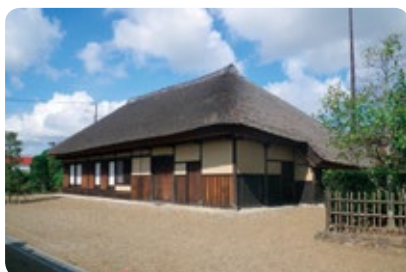
国指定重要文化財平井家住宅
