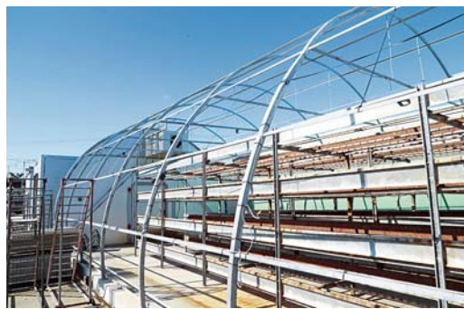
台風15号の強風でハウスも大きな被害を受けましたが、めげずにおいしいマッシュルームを届けています
