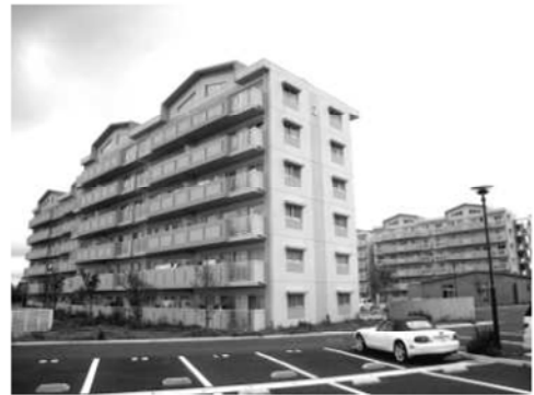
▼県営結佐アパート及び市営結佐住宅
