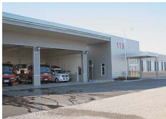
新設された江戸崎消防署桜東分署
