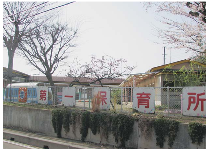
解体工事が予定されている旧江戸崎第一保育所
