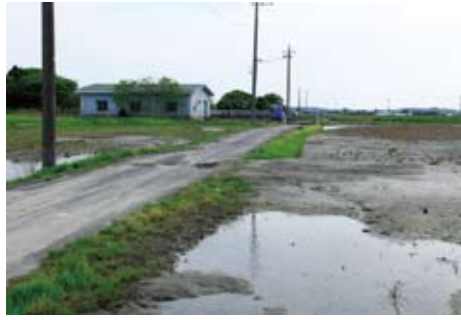
▲液状化により道路が陥没し、田んぼからは、道路よりも高く砂が吹き出した。
