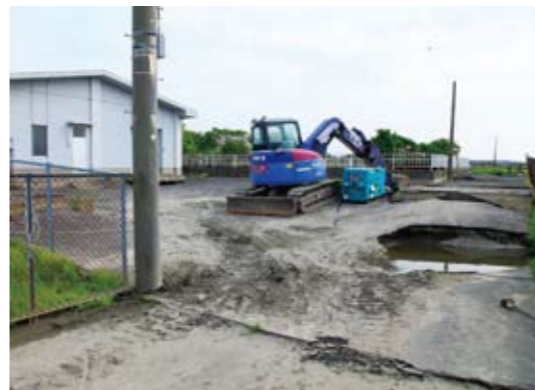
▲結佐工区に水を送れなくなった結佐六角用水機場。現在、復旧に向けて工事を行っています。
