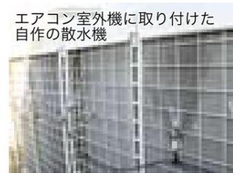
エアコン室外機に取り付けた自作の散水機
