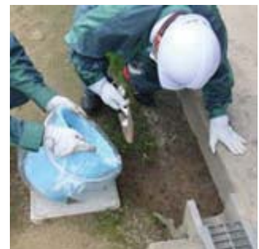
軒下・雨樋の清掃
