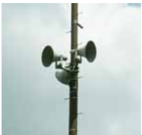
屋外防災行政無線スピーカー
