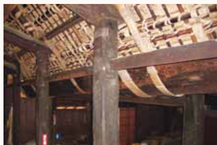
△分棟型・塙家（笠間市）② 座敷棟と釜屋棟の間の大きな木製雨樋
