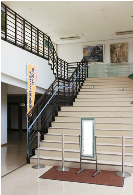
手すりを増設した2階図書室への階段 (江戸崎公民館)
