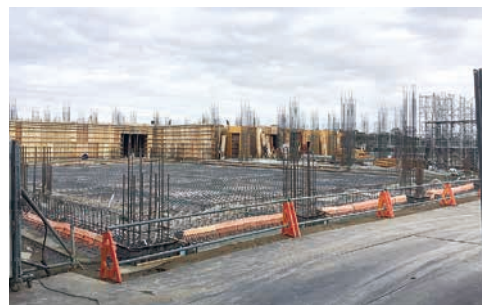
建設中の桜川小学校
