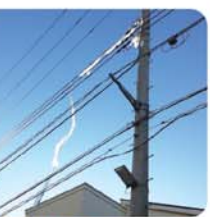
電線にビニールが引っかかっている
