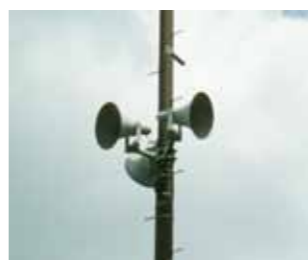
屋外防災行政無線スピーカー
