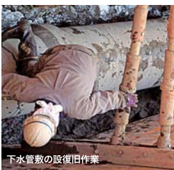
下水管敷の設復旧作業
