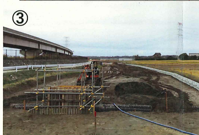
③ 工事用道路を造成しています。事前に耕土を剥ぎ取り、シートを敷いて土を盛っていきます。
