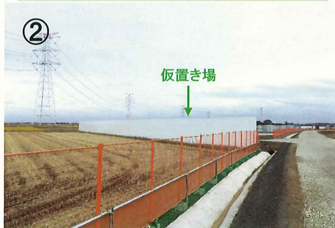
② 工事の土が、仮置き場で保管している耕土や周辺の田んぼに混ざることが無いよう、目隠し板を設置しています。
