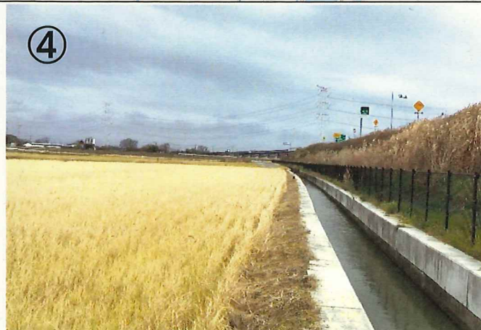
④ この範囲では1月から本格的に工事用道路の造成が始まります。
