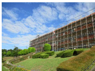
外壁塗装完了
