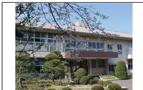
校舎 S54年建築(未改修)
