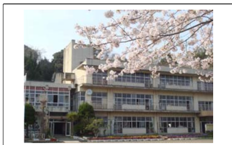
校舎 S46年建築(未改修)
