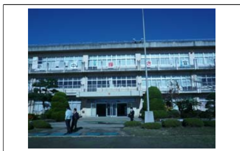
校舎 S51年建築(未改修)
