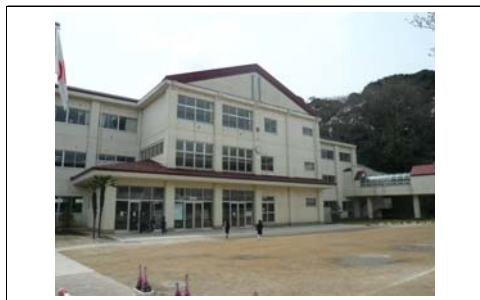
校舎 S46年建築(未改修)
