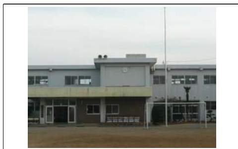
校舎 S44年建築(未改修)
