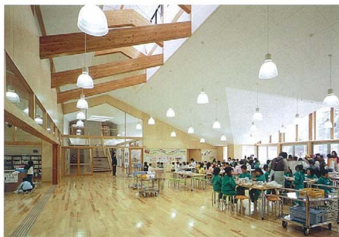
校舎のほぼ中央に位置する多目的教室兼ランチルーム。左はオープンに連続した図書室。屋根の勾配、ハイサイドライトの位置、軒の高さが内部空間の形状を決定づけている
