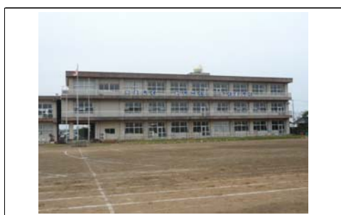
校舎 S45年建築(未改修)
