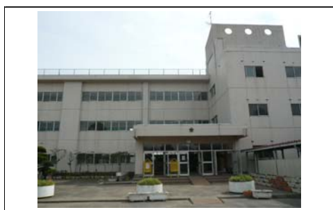
校舎 S55 年建築(未改修)
