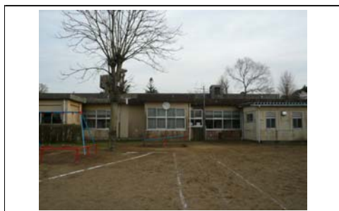
校舎 S39年建築(未改修)
