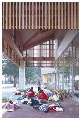
大屋根と連続してつくられた正面玄関ポーチの深い軒。ゆとりのあるスペースで、雪の浸入を抑制する
