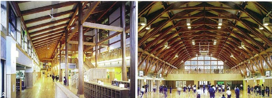
1 グラウンド側から見た校舎西側外観 2 2層吹き抜けの今庄ホール。ここで、多くの児童たちは帰りのバスを待つ 3 東面にガラス張りの大開口部をつかったアリーナ
