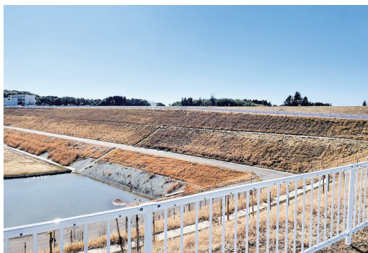
2工区に設置された貯水池
