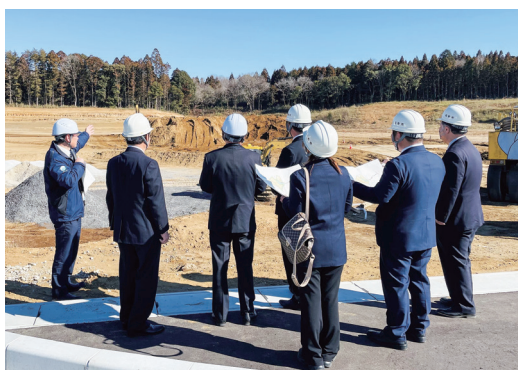
稲敷工業団地2工区の造成状況について説明
