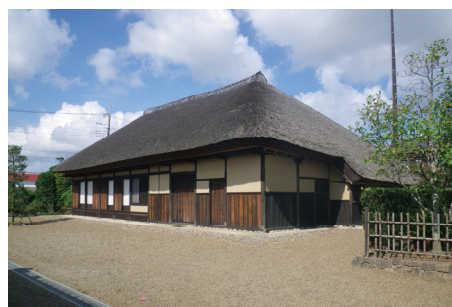
●重要文化財 平井家住宅
