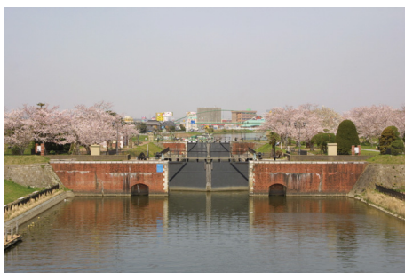
●重要文化財 横利根閘門
