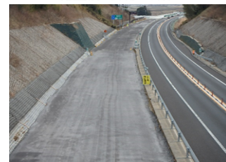
施工前（片側1車線）
