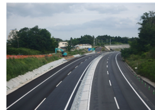
施工後（片側2車線完成）
