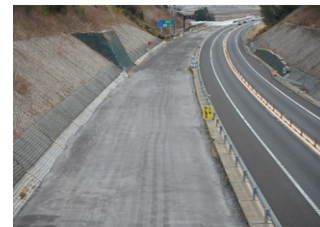
施工前（片側1車線）
