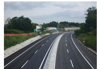
施工後（片側2車線完成）
