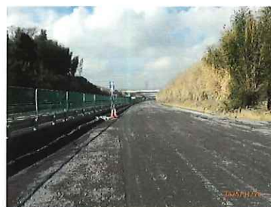
3工区現地写真
