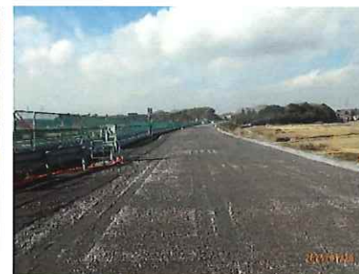
4工区現地写真
