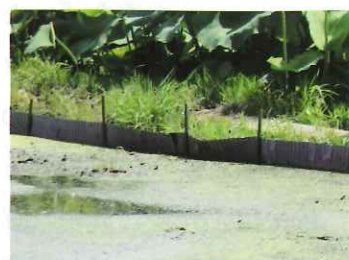
図2 波板により畦畔補強した例
