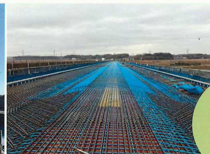
鉄筋の配筋状況
