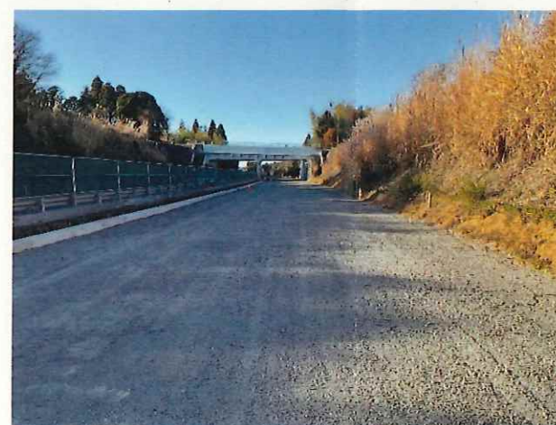
3工区現地写真
