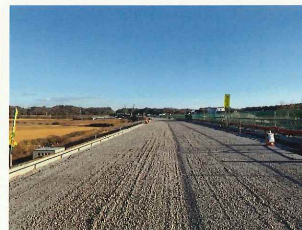
4工区現地写真
