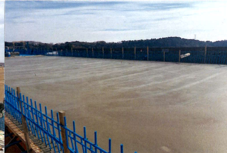
【江戸崎橋】①床版工の施工を行っております。（コンクリート打設中および打設完了後の状況）
