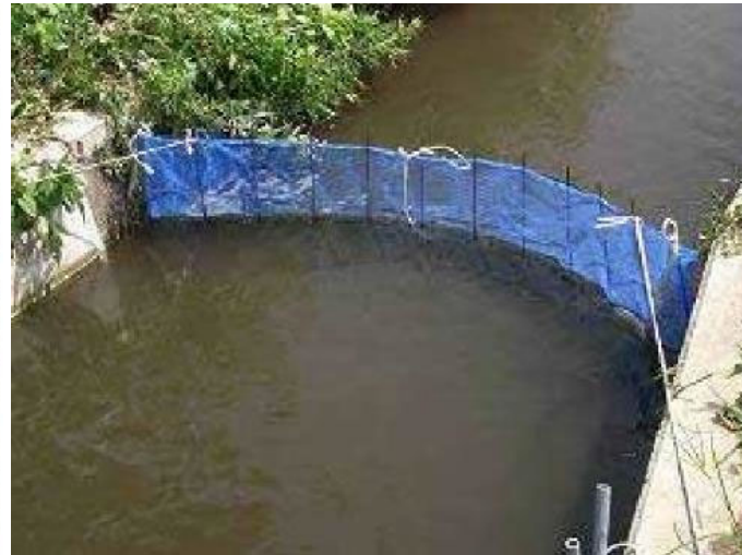
流出防止を目的とした網の設置例
